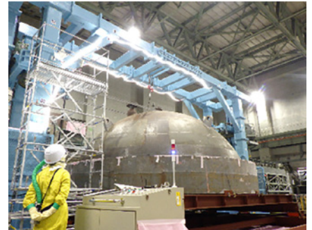
原子炉領域である原子炉压力容器上蓋の解体では、青色の大型バンドソー(切断機械)の刃が降下して、压力容器上蓋を縦に切断していく。
