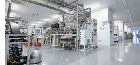
ワンフロアに最先端の測定・実験装置が並ぶセンター内部
