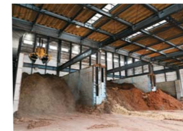
山積みされた燃料チップ、1日200t以上消費されるため大型ダンプが頻りに補充
