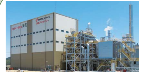
多気バイオパワー 全景
