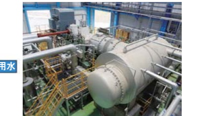
発電機・蒸気タービン・復水器が一列に並びシンプルな構成で、排気損失が少なく、タービンの高効率化を実現
