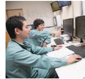
火力発電の運転経験で培ったノウハウを活かし24時間制御・監視
