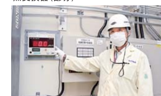
圧力容器の外壁に設置されている線量計は「0.0μシーベルト」を表示
