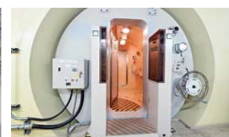
原子炉格納容器の出入口は潜水艦にも使われている高気密ハッチ
