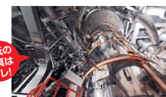
原子炉から高温の熱を取り出すための熱交換器（部分）
