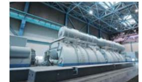
ボイラで作った蒸気はタービンに送られ、それに直結した発電機で100万kW(4・5号機)の電気を起こす。
