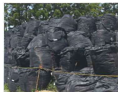
仮置き場に積み上げた除染土の土嚢。2021年度に中間貯蔵施設への移送がほぼ完了する予定。
