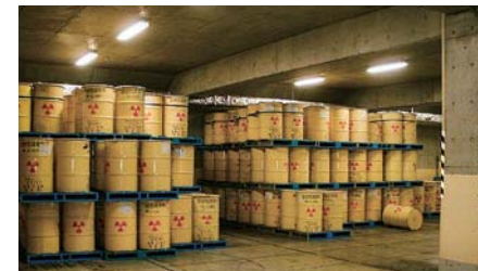
固体廃棄物貯蔵庫 写真提供:東京電力ホールディングス(株)
