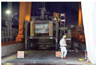
構内従事者は1日当たり約4,000人、水処理施設はコロナ禍でも昼夜3交替で廃炉作業が行われています。
