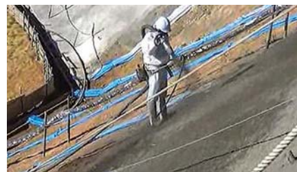
構内のフェーシング作業 写真提供:東京電力ホールディングス(株)
