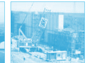
①中部電力(株)浜岡原子力発電所 (防波壁設置工事の様子)
