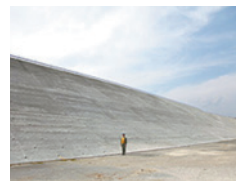
西側改良盛土
