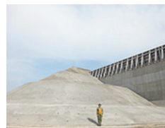
東側改良盛土
