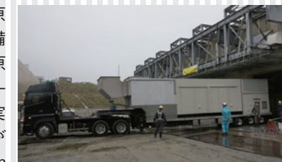
ガスタービン発電機の搬入の様子 2015年4月3日
