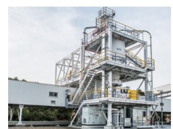
下水汚泥の炭化燃料と混合設備
