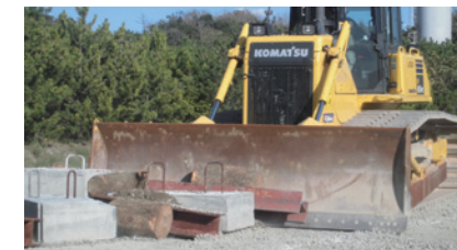
アクセス路を確保するための、がれき撤去訓練
