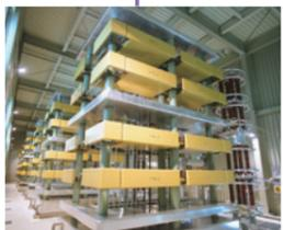
周波数変換装置 (サイリスタバルブ) で直流を交流に、交流を直流に変換する
