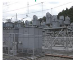
波形のひずみで生じる不要な高調波を交流フィルタで取り除く
