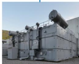
変圧器で周波数変換装置の運転に適した電圧まで下げる
