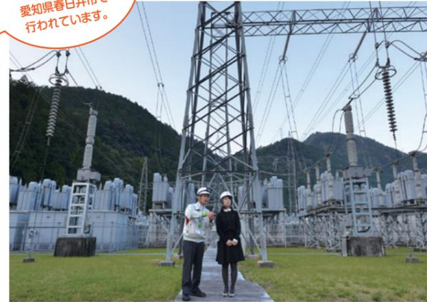
周波数を変換した60ヘルツの電力は佐久間西幹線 (送電線) 経由で愛知県春日井市へ、50ヘルツの電力は東幹線を経由して西東京変電所へ送られる。
