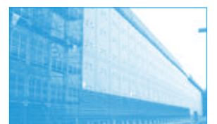
②浜岡原子力発電所防波壁 写真提供:中部電力(株)
