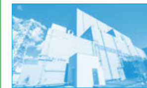
①浜岡原子力発電所原子炉建屋 写真提供:中部電力(株)
