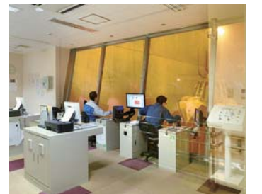
ごみクレーンの運転室。焼却灰はピット内に均等に散布。夜間は自動運転となる。
