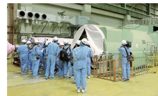
解体作業を報道陣に公開
