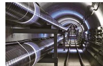
工事中の海底シールドトンネル内の燃料ガス導管。現在は埋め戻され、人は通れない。
