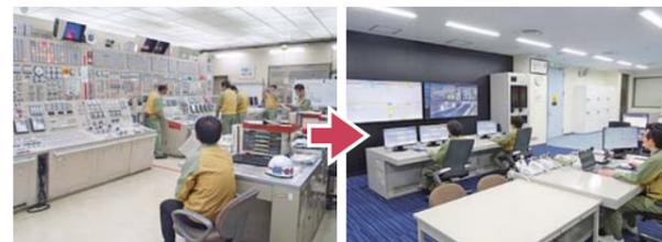
多くの計器が並んでいた中央制御室(左)もシステムの自動化でスッキリ(右)。制御・監視が数台のパソコンやモニターでまかなえ、少人数で運転します。
