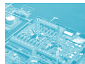
①川越火力発電所
