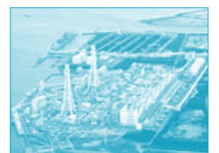
②碧南火力発電所
