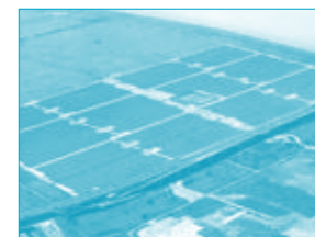
①木曾岬干拓地メガソーラー発電所 写真提供:丸紅㈱
