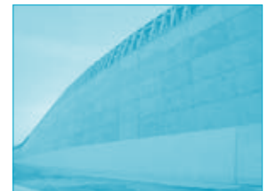
①浜岡原子力発電所防波壁
