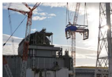
廃炉作業中の福島第一原子力発電所3号機 提供:朝日新聞社
