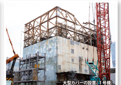
大型カバンの設置(1号機)
