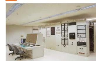
名城変電所は通常、無人運転で、制御室には変電所の運転監視に必要なすべての情報が集められます。変圧器や開閉器の情報は制御装置で処理された後、常時人のいる「中村電力センター」や「給電制御所」に専用の光ファイバーケーブルで送られ、設備の監視・制御にあたっています。変電所内の火災や侵入者、照明の点灯状態の監視も行っています。
