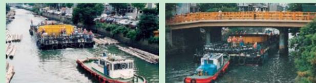
専用船によるケーブルの水上輸送 干潮時での橋下通過
