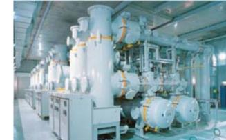
27.5万Vで送られてきた電気の流れ方を変えたり、故障した箇所を切り離したりする「スイッチ」の役割をする装置です。従来は放電を防ぐため、装置同士の間隔を確保する広い空間が必要でしたが、電線・スイッチなどの装置を絶縁性の高い六フッ化イオウガス(SF6)※1を封入した金属タンクで密封し、面積を14分の1、体積を32分の1に小型化し、安全性・信頼性も向上させました。 ※1: 絶縁性能は1気圧で空気の3倍、不燃・無臭・無色、生物に無害で腐食性・爆発性もありません。
