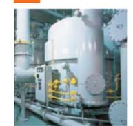
変電所で最も重要な装置で、変圧器1台で一般家庭の約15万軒分に電気を送る能力を持っています。重量が約420トンあるため最深部の地下5階に設置され、万一、火災が発生しても延焼しないよう2基は部屋を分離されています。また、従来は変圧器油で冷却と絶縁を行っていましたが、この変圧器ではパーフルオロカーボン※2液とSF6ガスを組み合わせて冷却・絶縁・不燃性を高めています。 ※2: 絶縁性能は変圧器油の1.3倍、不燃・無臭・無色、生物に無害で腐食性・爆発性もありません。
