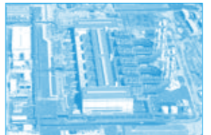
②西名古屋火力発電所 写真提供:中部電力(株)
