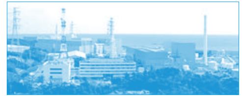
浜岡原子力発電所 写真提供:中部電力(株)
