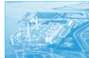
①碧南火力発電所
